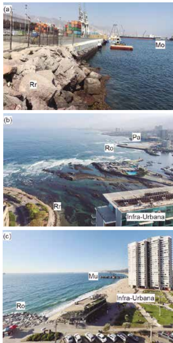
Figura 1. Desarrollo portuario (a) y urbano (b) en Antofagasta, (norte de Chile) y desarrollo urbano en Viña del Mar (Chile central) (c); Rr= defensas usando Rip-rap; Mo= molo de abrigo; Ro= rompeolas; Pa= playa artificial; Mu= muelle. Fotos a y b N. Lagos, foto c, cortesía Dr. R. García-Huidobro.
